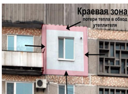
Рисунок 2. Утепление фасада панельного дома фрагментами
